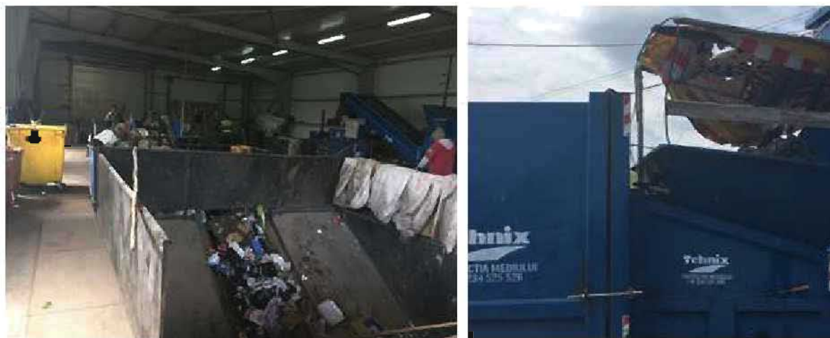
Figura 5-3: Imagini fotografice stația de sortare și transfer Hârlău
